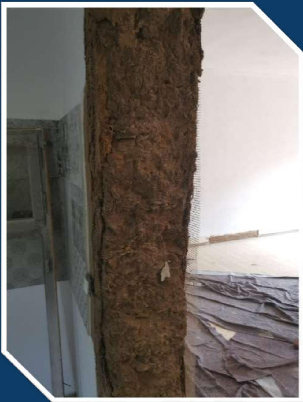
Die Herstellung und Verarbeitung von Stampflehm gleicht der von Beton. Man füllt ein Gemisch aus Lehm, Stroh, Sand und Steinen in eine Schalung und verdichtet diese Masse in regelmäßigen Abständen. Durch die fortlaufende Schalung gibt es keine Fugen und das Gebäude ist dicht. Zum anderen wird im Gegensatz zu Stein- oder Holzbauten wenig Material benötigt. Zumeist befindet sich der benötigte Baustoff schon auf dem Grundstück. Ein weiterer Vorteil ist, dass diese Konstruktion brandsicher ist.
